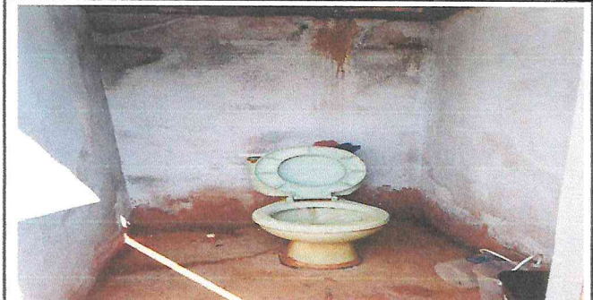
SUSTITUCION DE INODORO
