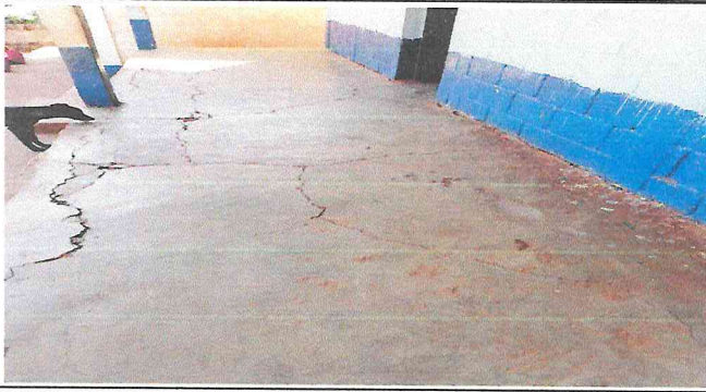
SUSTITUCION DE PISO CERAMICO
