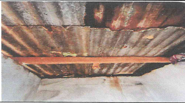
SUSTITUCION DE LAMINA POR LAMINA TROQUELADA
