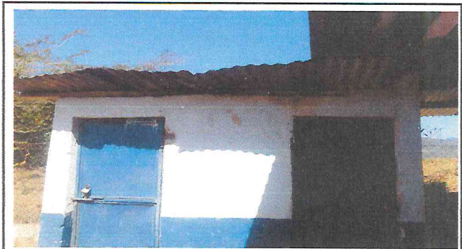
SUSTITUCION DE PUERTA E SERVICIOS SANITARIOS
