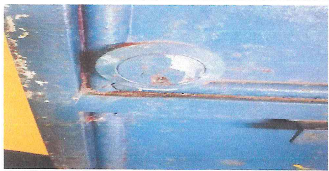
SUSTITUCION DE CHAPA
